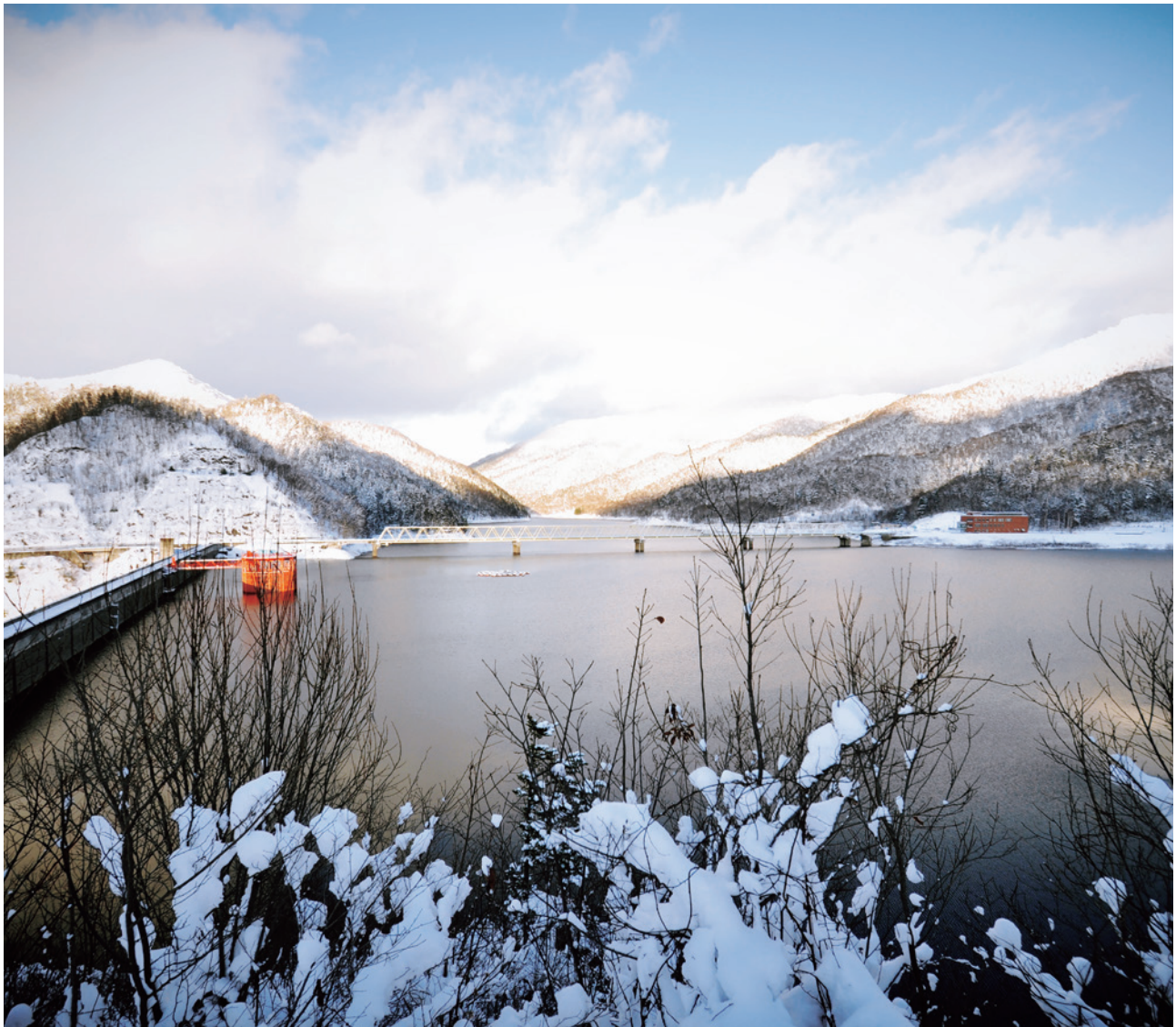
令和5年12月1日 岩尾内ダム
